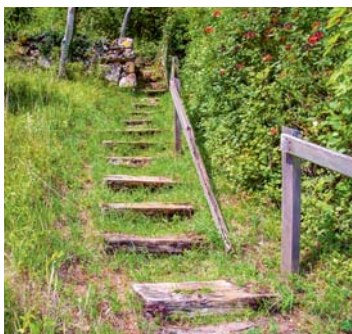
Defekte Tritte, vorstehende Eisen und morsche oder defekte Geländer bergen grosse Gefahr in sich. Mit Ihrer Meldung an die Aargauer Wanderwege helfen Sie Schwierigkeiten, Defekte oder Risiken zu vermeiden.
